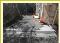
Des travaux de drainage ont été réalisés pour l'appartement du rez-de-chaussée de l'ancienne mairie. Désormais, avec l'installation d'une VMC et d'un nouveau radiateur, cet appartement ne devrait plus avoir de problèmes d'humidité.
